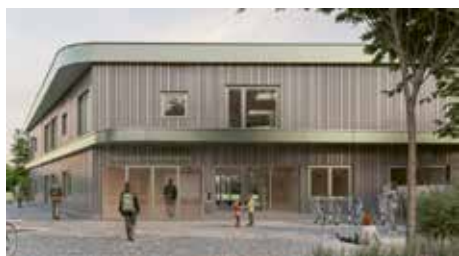
Kindergartenbau 2026: Aufträge im Gesamtvolumen von rund 2,4 Mio. € vergeben.
