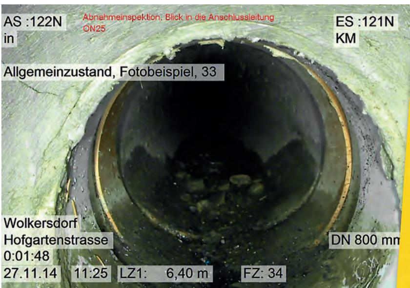
Ein Bild wie es nicht sein sollte – Kanalrohr mit leichten Verschmutzungen.
